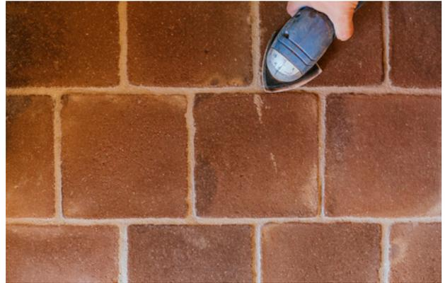
1.6. Utilizaremos el punzón o lijadora para eliminar restos de obra que no hayan sido eliminados en el proceso de limpiado.
