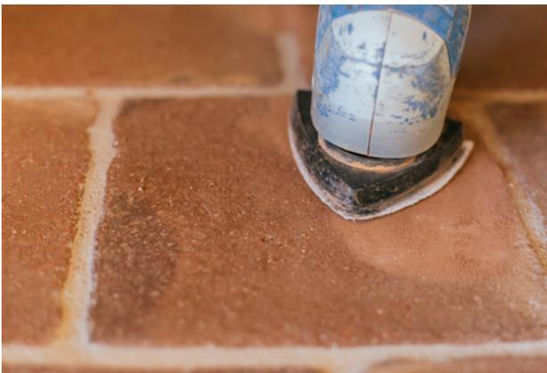
1.7. Detalle de eliminación de restos con la lijadora.
