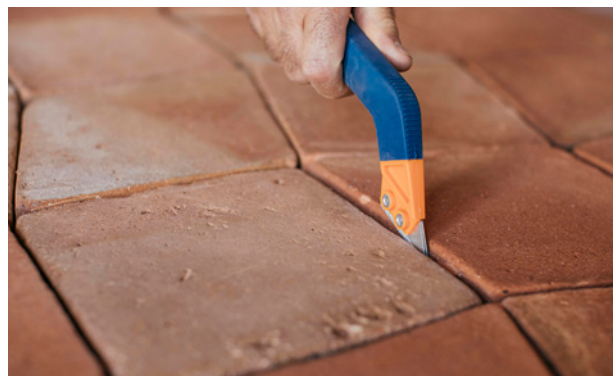
Limpieza de juntas
