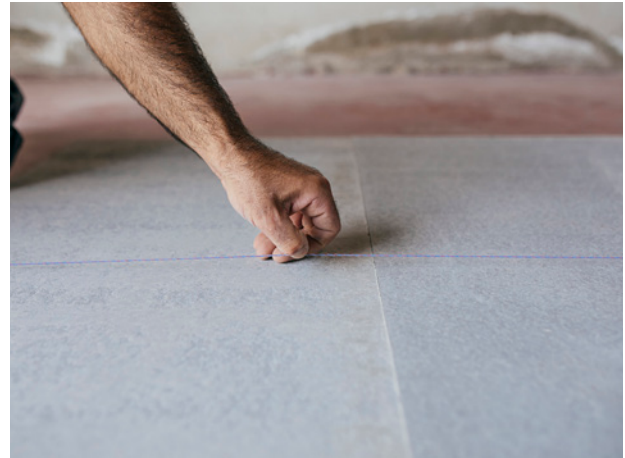
Remplanteo de líneas de colocación con tiralíneas
