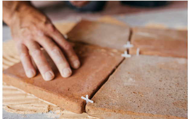
Ajuste de juntas de colocación
