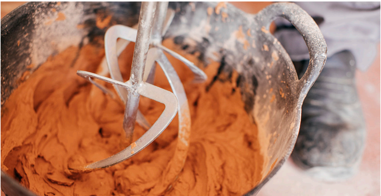
Operación de mezcla del adhesivo
