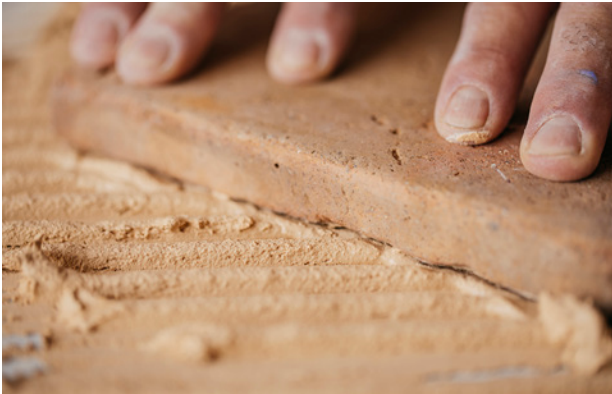
Colocación de baldosa
