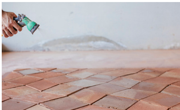
Humedecido de piezas previamente al rejuntado
