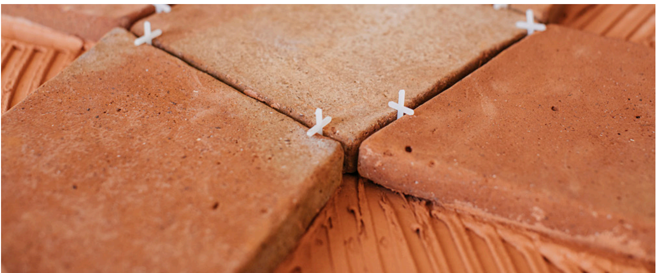
Juntas de colocación
