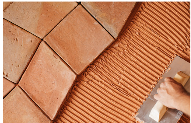
Adhesivo peinado con llana dentada sobre soporte
