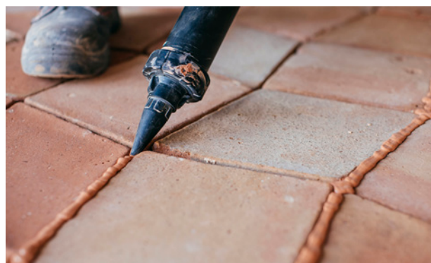
Sellado de juntas con material de rejuntado
