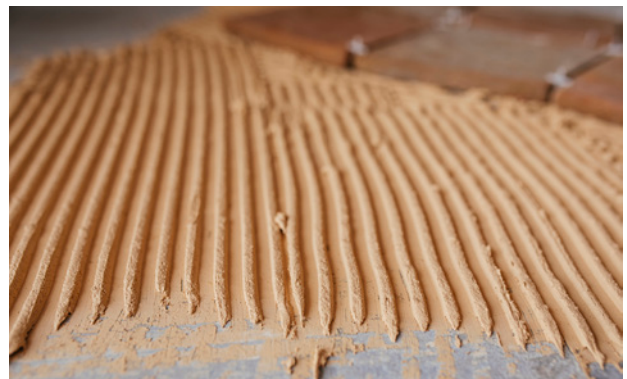
Adhesivo sobre soporte de colocación
