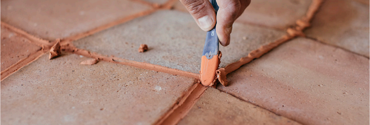
Llaguero para retirada de exceso de material de rejuntado
