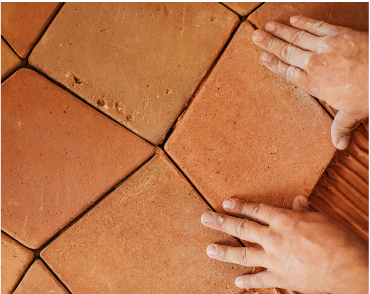
Colocación de baldosas
