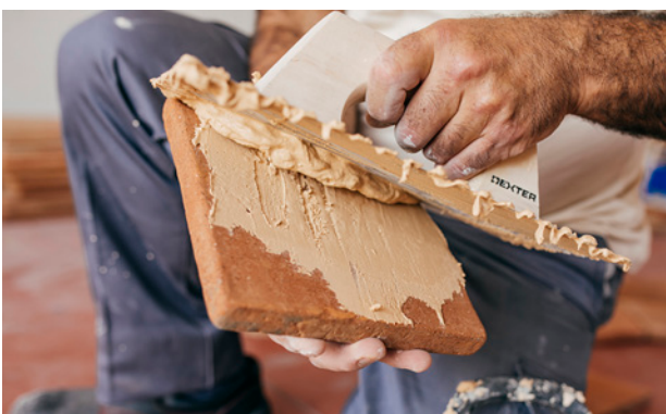
Aplicación de adhesivo en reverso de baldosa
