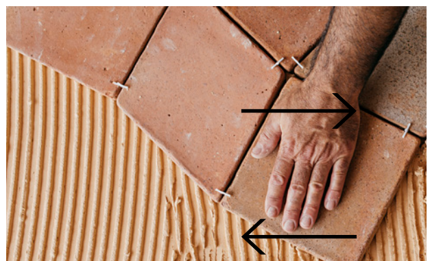
Colocación de baldosa
