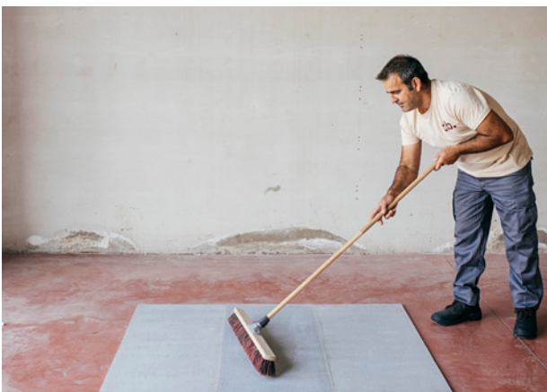
Limpieza de soporte de colocación
