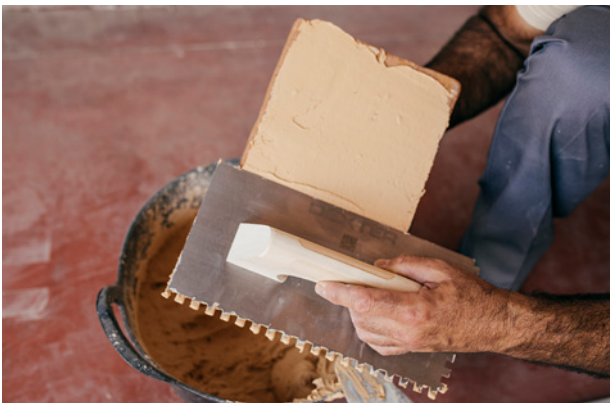
Aplicación de capa de adhesivo en reverso de baldosa
