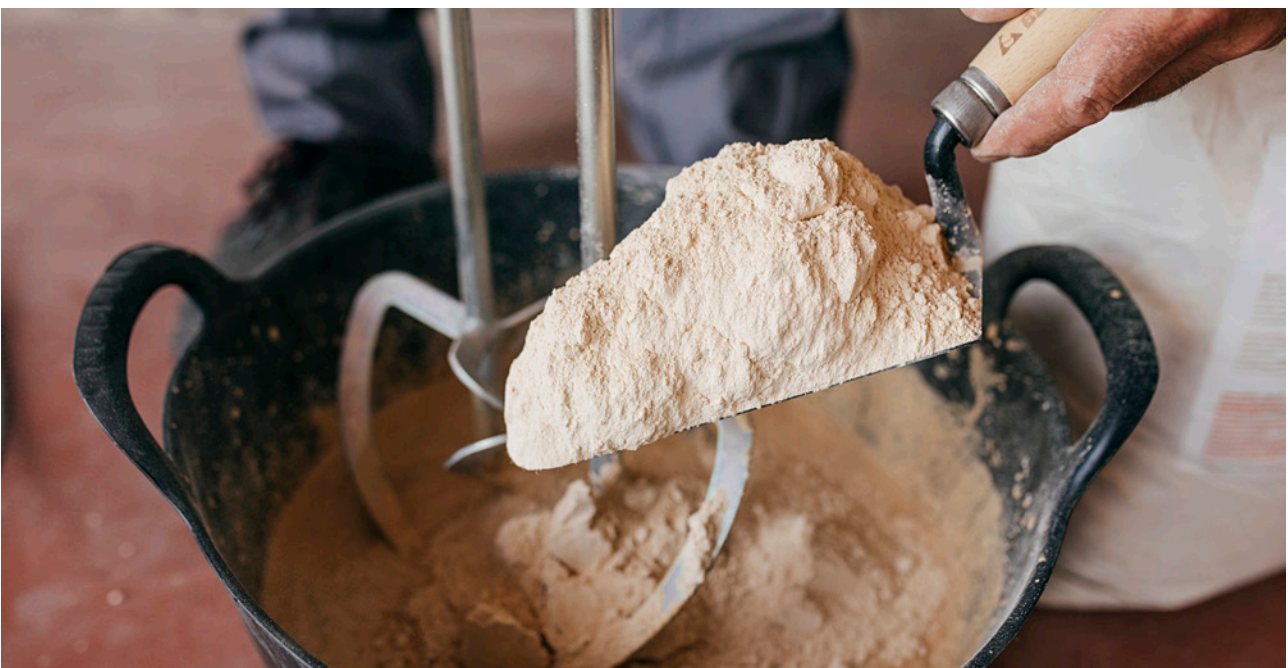
Preparación del adhesivo
