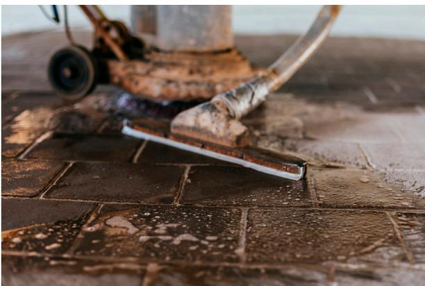
**1.3.** A continuación, realizamos un secado rápido con aspiradora de líquidos, en caso de que el suelo no quede lo suficientemente limpio habrá que repetir el proceso.
