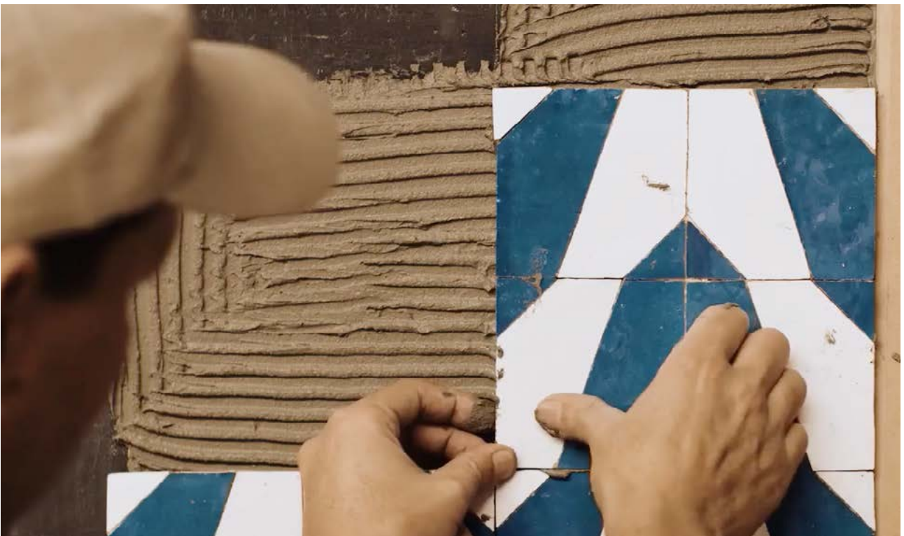
Zellige instalación de baldosas.
